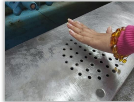
Sử dụng hệ thống thông gió cục bộ (LEV) – các ví dụ
